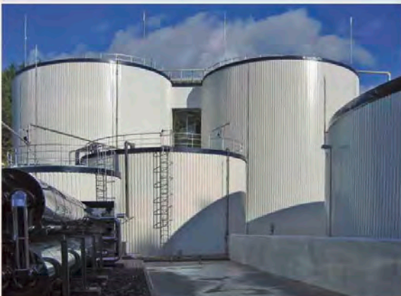
Réacteurs avec couvertures en béton armé Isolation et bardage métallique
