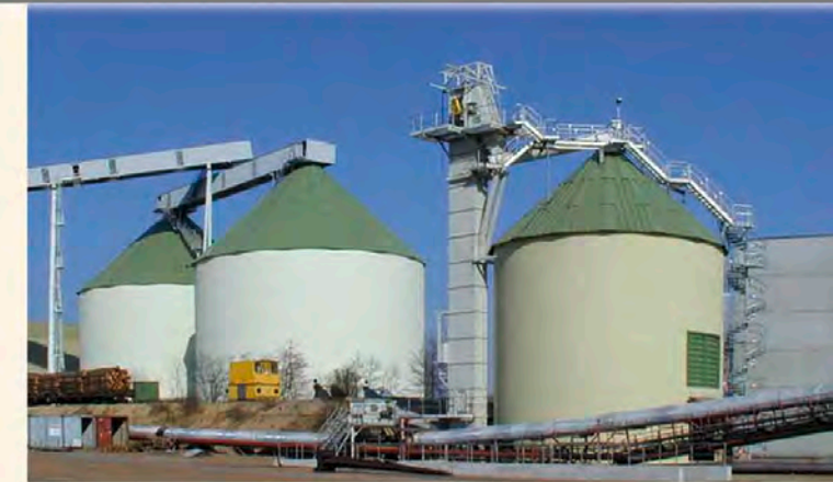
Silos à grandes capacités à toit conique métallique pour copeaux
