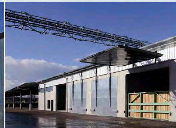
Installation de fermentation en milieu solide avec portail d'aération ouvert
