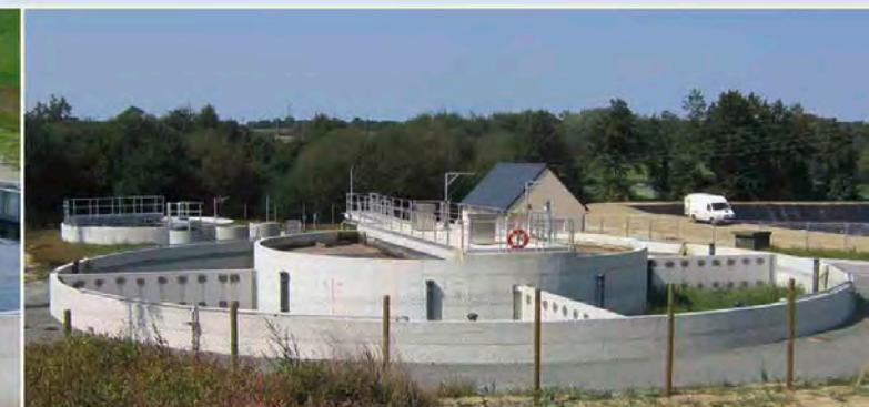
Clarificateurs spéciaux avec réservoirs intérieurs et murs de séparation
