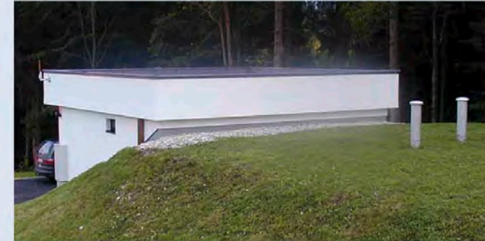
Réservoir d'eau potable couvert de terre avec bâtiment d'exploitation
