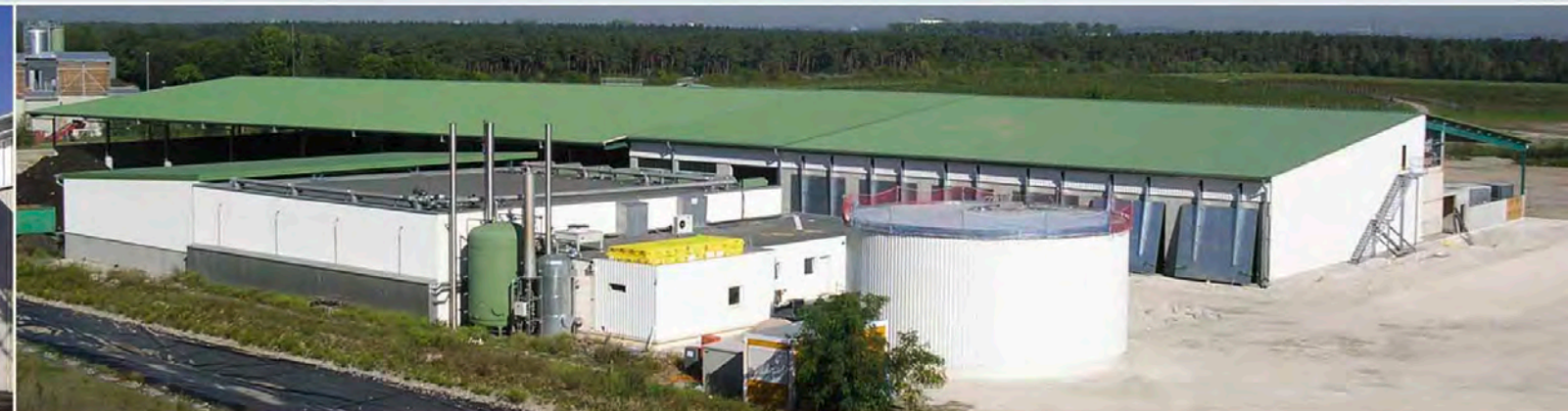
Installation de fermentation en milieu solide avec bâtiment de réception, bâtiment d'exploitation et percolateur
