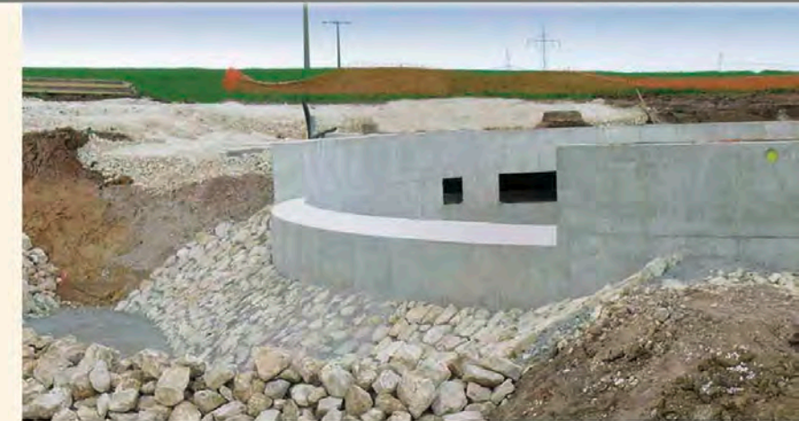
Bassin d'orage avec seuil de déversoir
