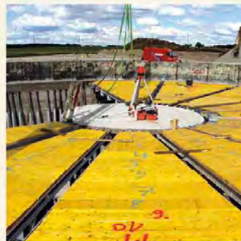
Pose de coffrage préfabriqué
