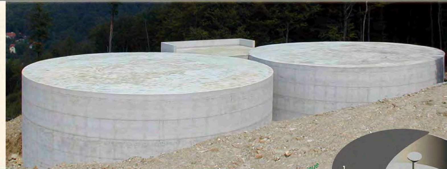
Réservoir d'eau potable (recouvert de terre)
