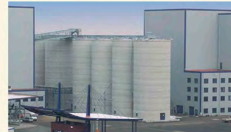
Silos à céréales avec couverture en béton armé et dalle intermédiaire
