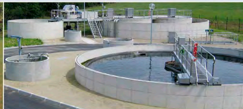
Station d'épuration avec regards de pompage
