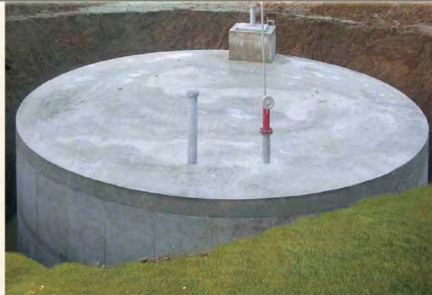
Réservoir d'incendie (enterré)
