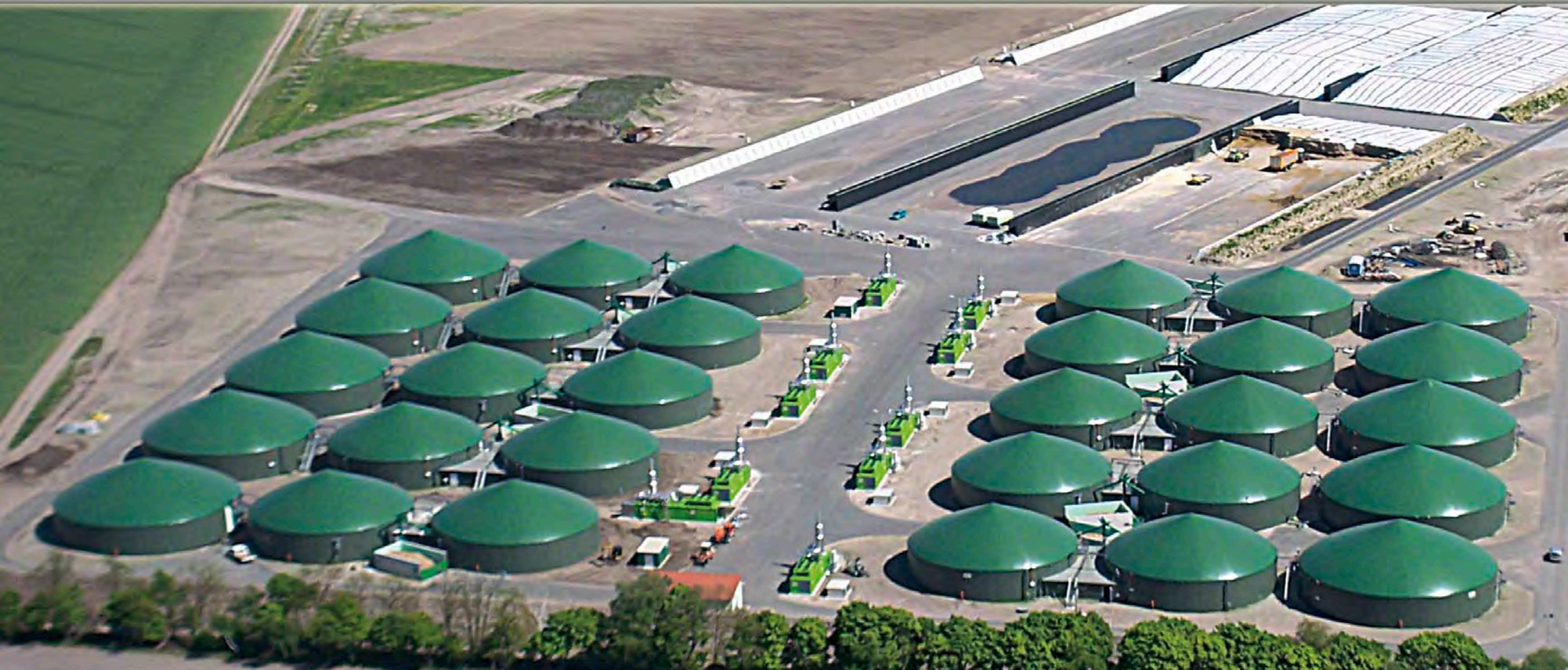
Méthaniseurs, digesteurs secondaires et stockage final, couverture bâche, isolation et bardage métallique
