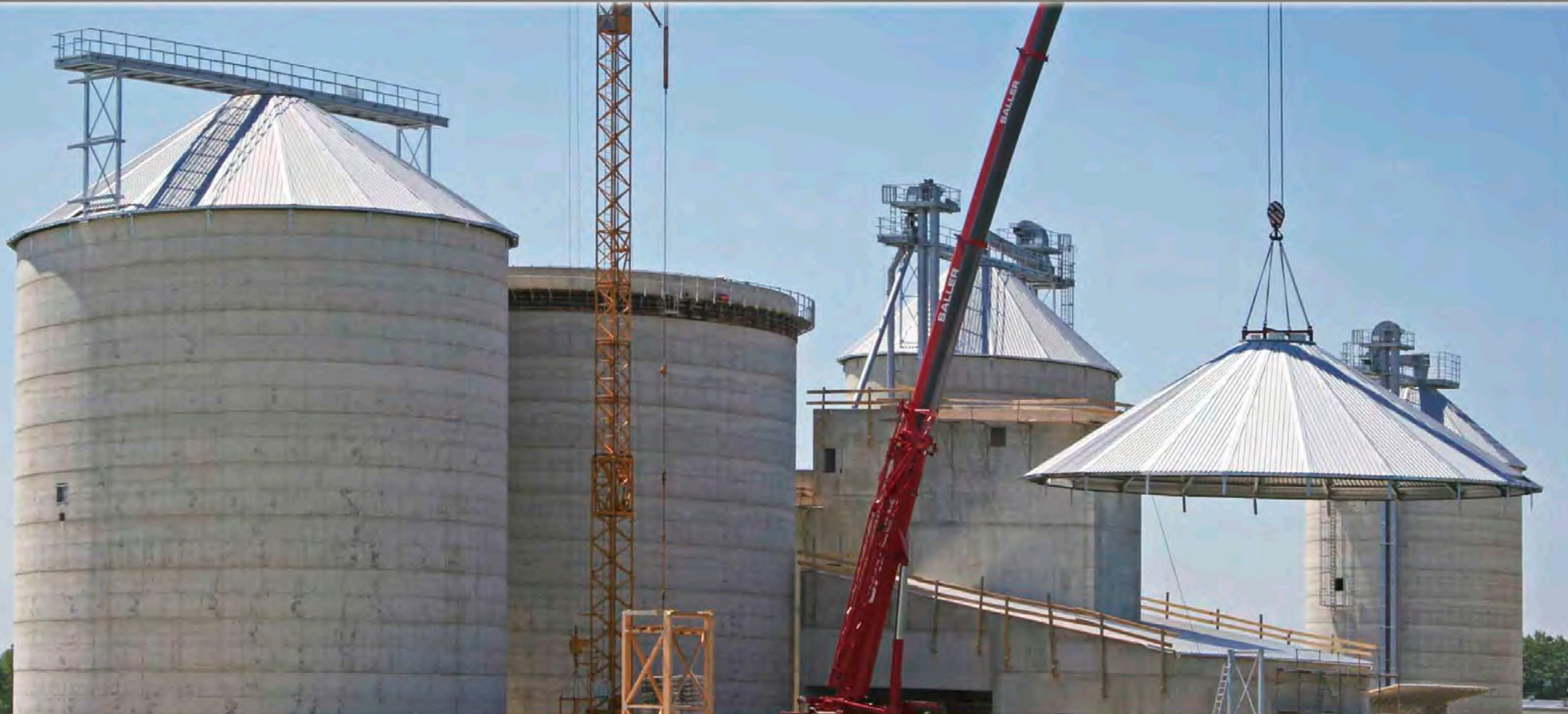
Silos à pellets - (Respectivement avec toit conique métallique et couverture métallique)
