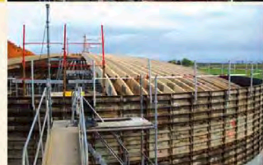
Pose de coffrage préfabriqué
